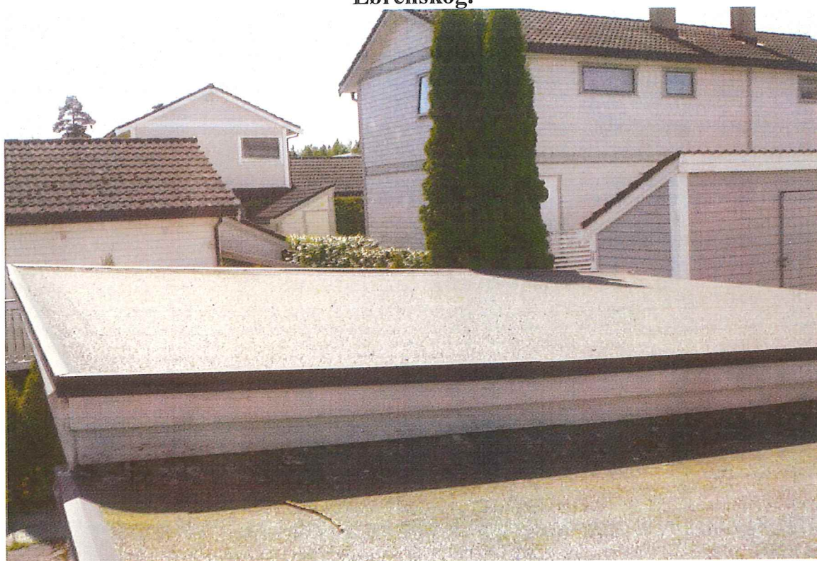
Tak/takflater og tekking.
