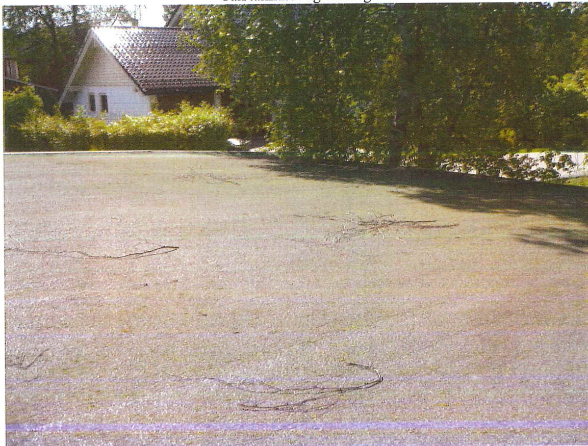
Tak/takflater og tekking.
