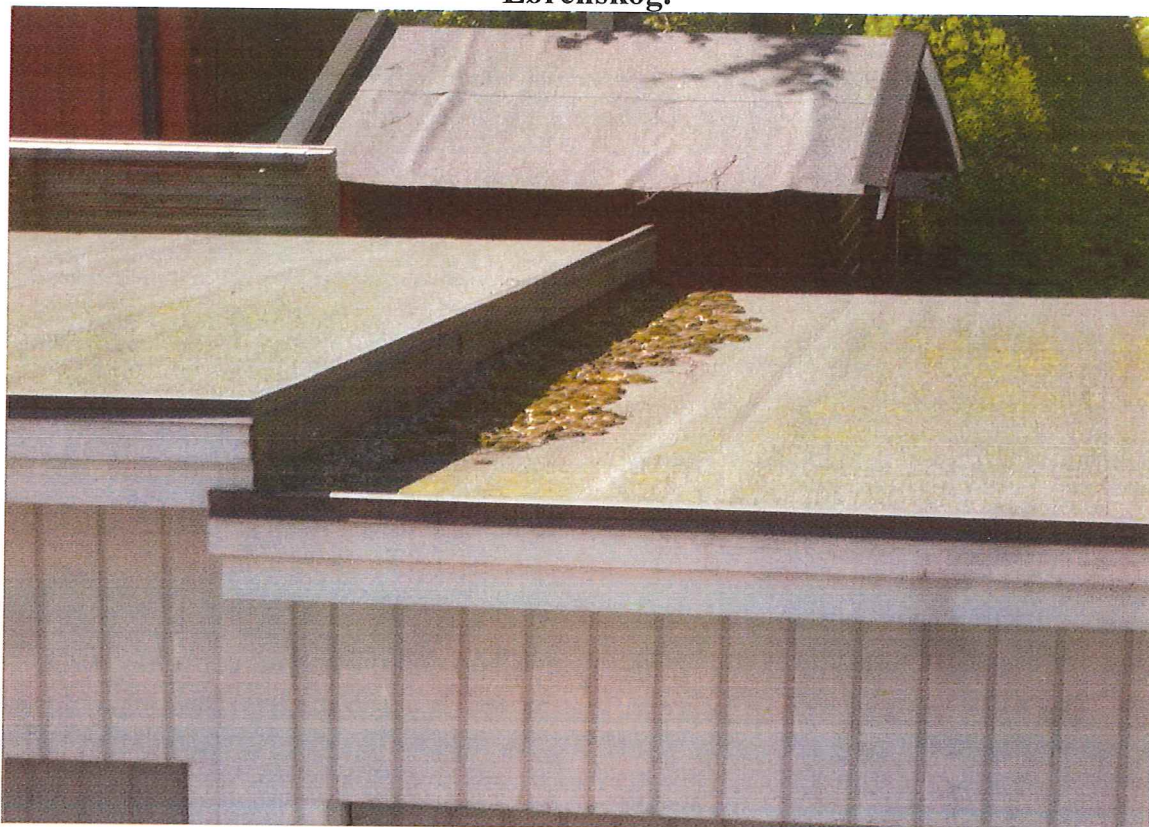
Tak/takflater og tekking.
